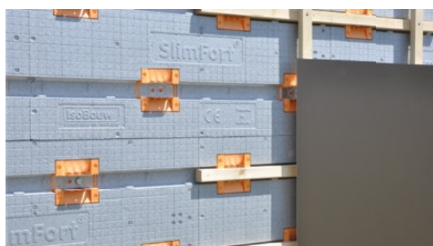
Wykończenie płytami kompozytowymi z aluminium
