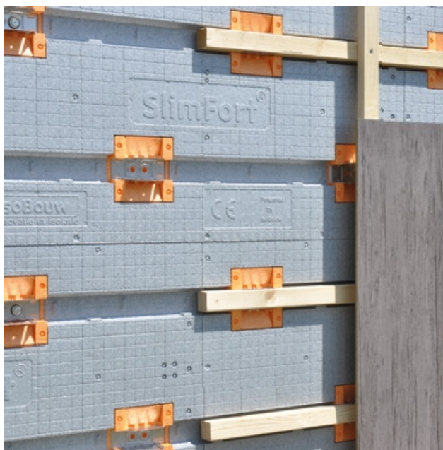
Wykończenie prasowanymi płytami z wełny mineralnej
