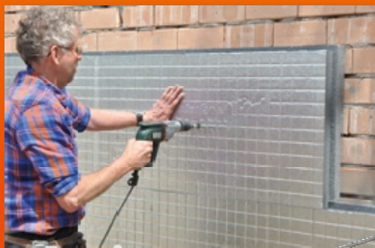
izolacja ścian szczelinowych
