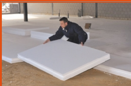
izolacja podłóg
