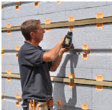
Krok 2: Montaż konstrukcji nośnej
