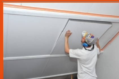
izolacja sufitu
