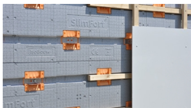
Wykończenie płytami z cementu włóknistego
