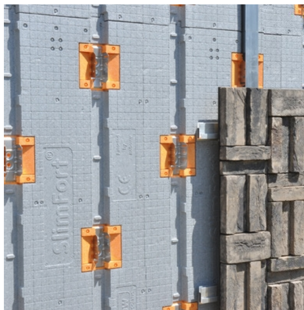
System nośny fischer z wykończeniem z listew ceglanych
